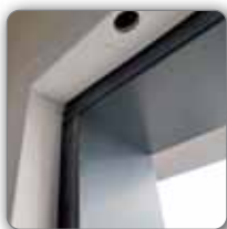
ADLO drážkové tesnenie v TERMO zárubni
